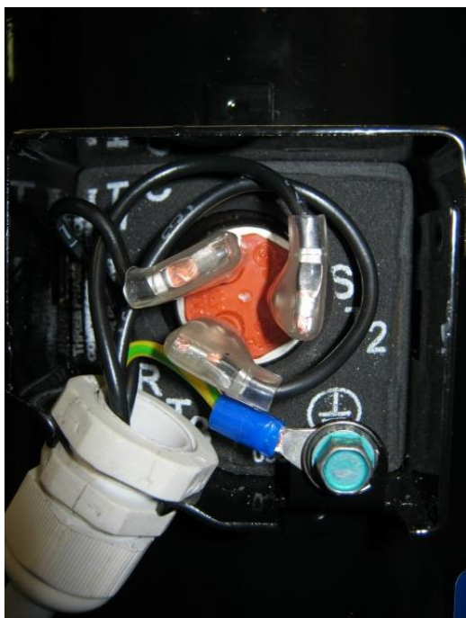
Рис. 14: Правильное подключение клеммной коробки IP21 с помощью кабельных муфт (ZB15K* - ZB45K*)
