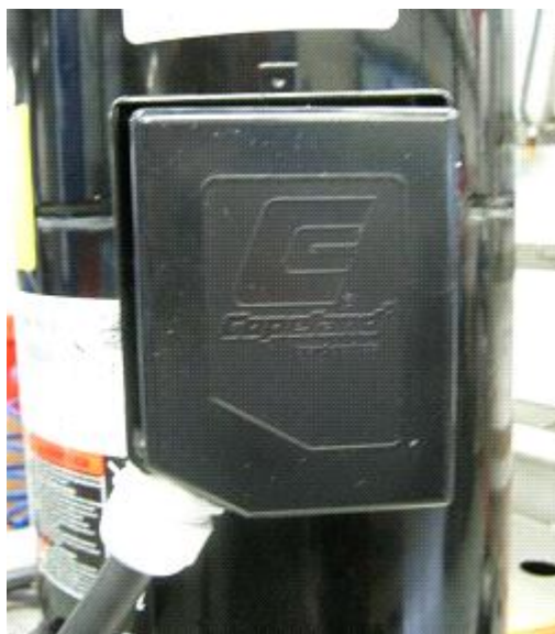
Рис. 20: Правильное электрическое подключение клеммной коробки IP21 с помощью кабельной муфты (компрессоры ZBD30K* - ZBD114K* / ZFD13KVE - ZFD25KVE / ZFD41K5E)
