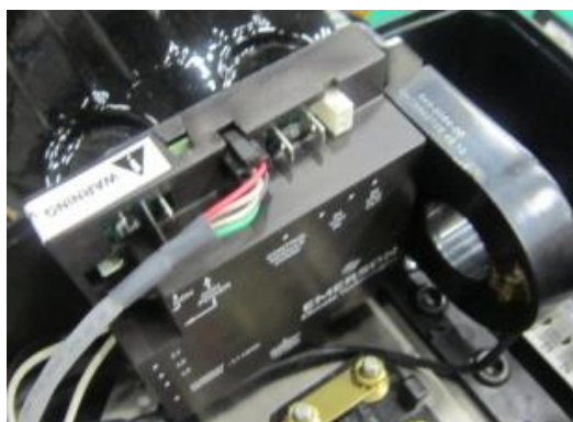
Rysunek 2: Moduł czujnika CoreSense Diagnostics w puszkii zaciskowej T-Box
