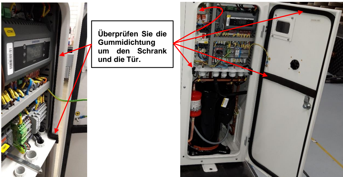
Abbildung 42: Sichtprüfung der Gummidichtung
