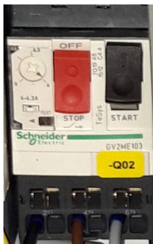
Figuur 29: Stroomonderbreker met overstroombeveiliging
