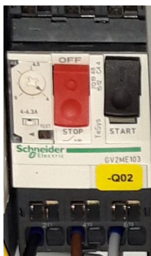
Figure 29 : Disjoncteur avec protection contre les surintensités
