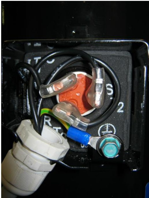
Rysunek 14: Prawidłowe podłączenie skrzynki IP21 z wykorzystaniem dławika (modele ZB15K* do ZB45K*)
